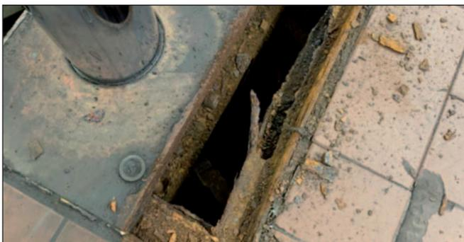
Der alte Kassettenrahmen ist durchrostet, hohes Sicherheitsrisiko
